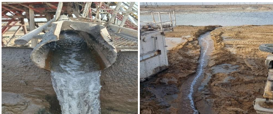
Рисунок 1. Территория вокруг буровой 1-скважины
