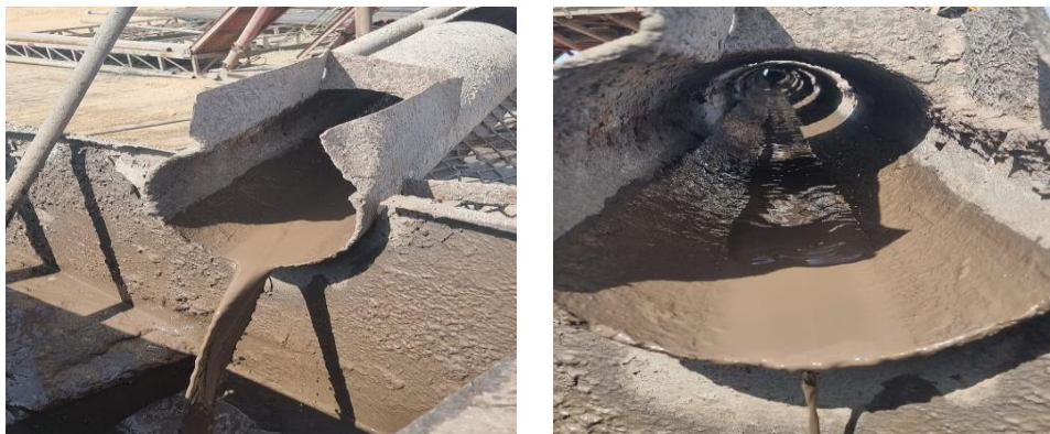
Рисунок 2. Интенсивный пульсирующий перелив при бурении 2-скважины
