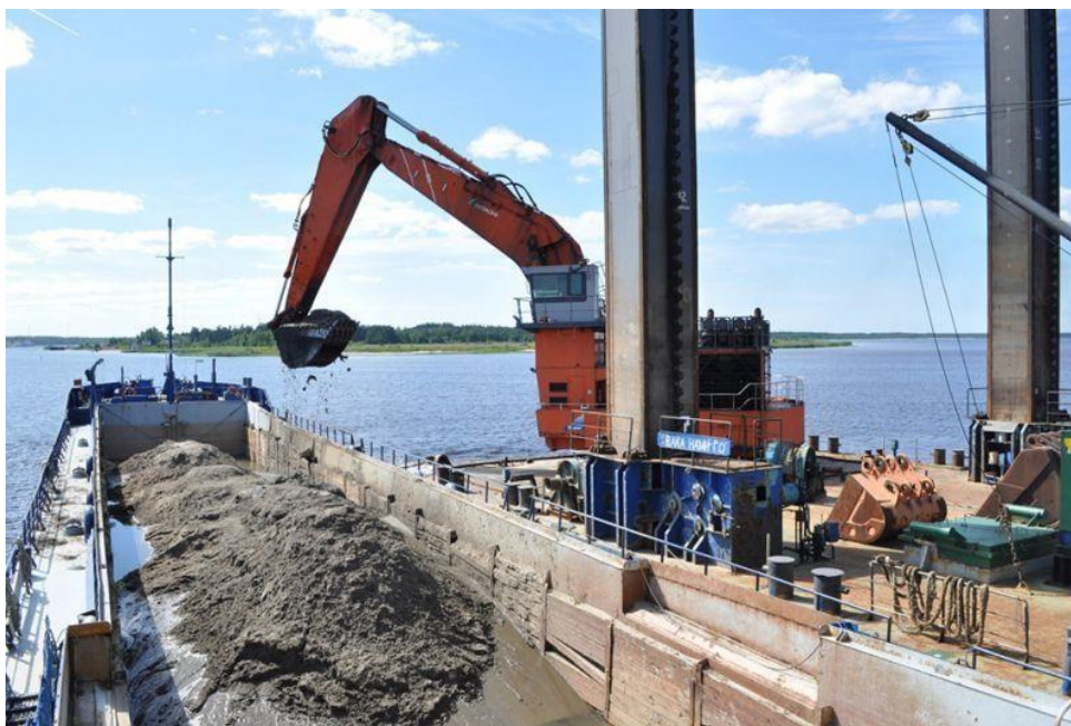
Рисунок2. Подача извлеченного грунта танговым землечерпательным снарядом в грунтоотвозную шаланду.
