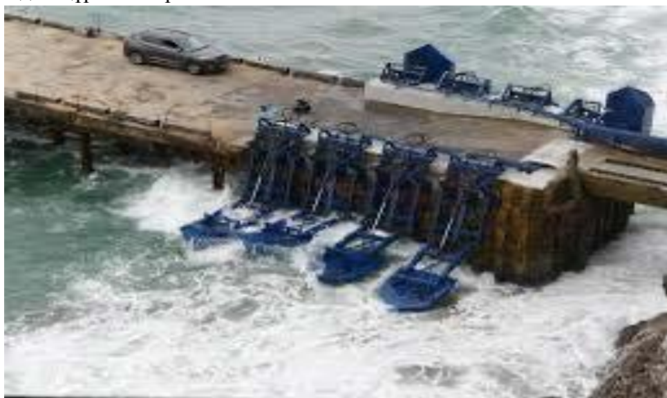
1-сурет - Толқынның көмегімен электр энергиясын алатын станция
