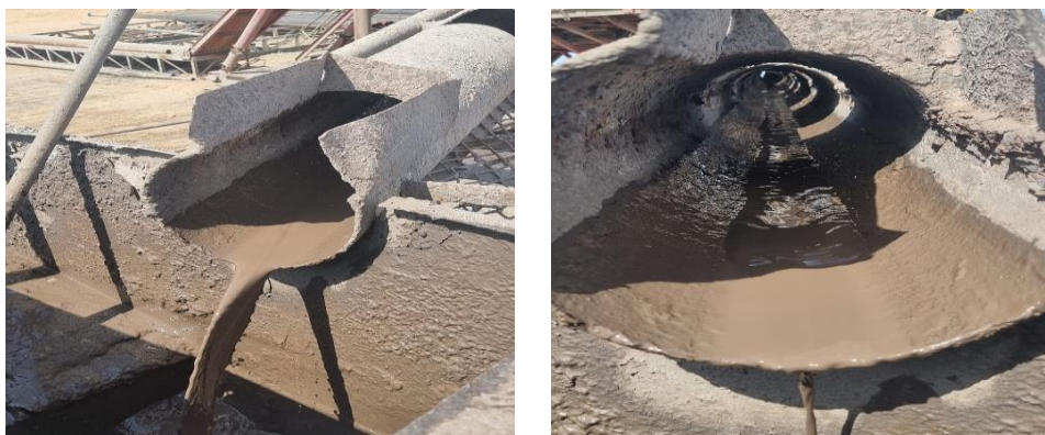
Рисунок 2. Интенсивный пульсирующий перелив при бурении 2-скважины
