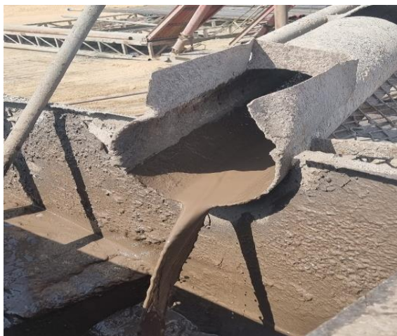
Рисунок 2. Интенсивный пульсирующий перелив при бурении 2-скважины
