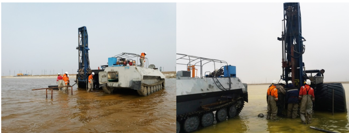
Сурет 3.2 - Инженерлік-геологиялық ұңғымаларды бұрғылау
