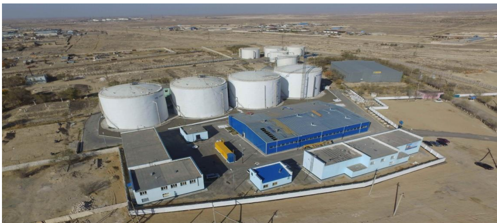
Сурет 6 - Жаңаөзен қаласын ауыз сумен қамтамасыз ету жүйесінің Волга өзенінен алынатын суды алдын ала тазарту кешені
