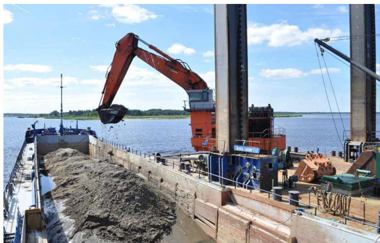
Рисунок 2. Подача извлеченного грунта штанговым землечерпательным снарядом в грунтоотвозную шаланду
