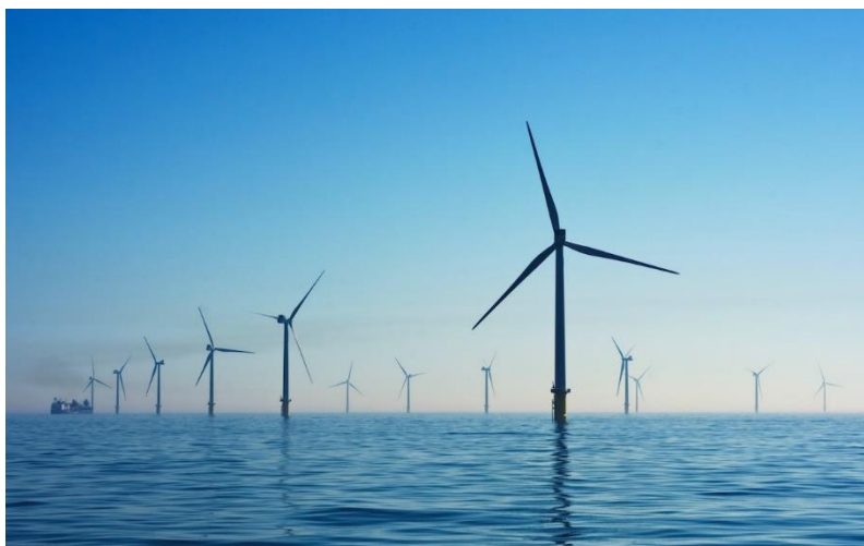
Рисунок 1. Морская ветряная электростанция
