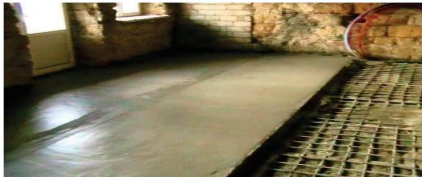
Рисунок 4-Поверхность пенобетонного основания
