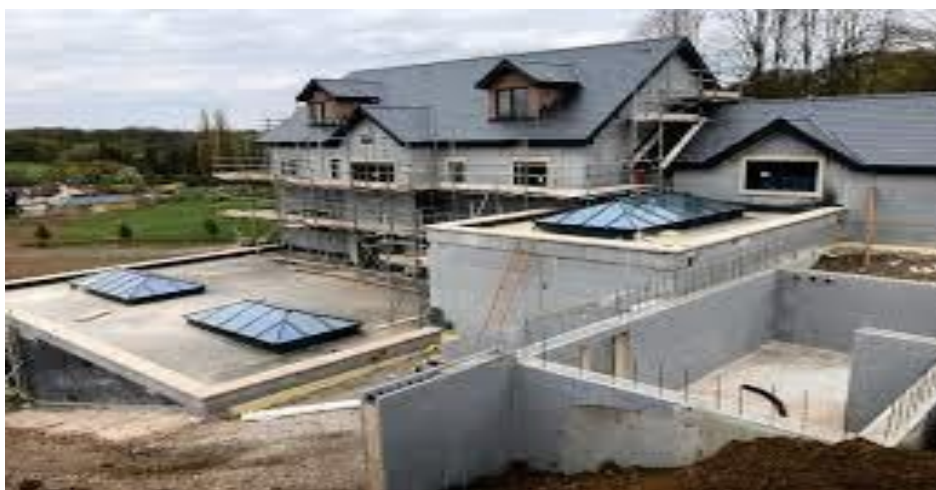
Рисунок 1- Строительство дома с применением технологии ТИСЭ
