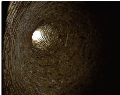
Сүрет 3 - Термос әсерін жасау үшін сабан кірпіштен өте қалың қабырғалар жасалған (яхчал, Иран). / Фото: punkufer.dnevnik.hr.
