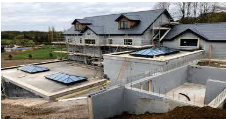
Рисунок 1- Строительство дома с применением технологии ТИСЭ
