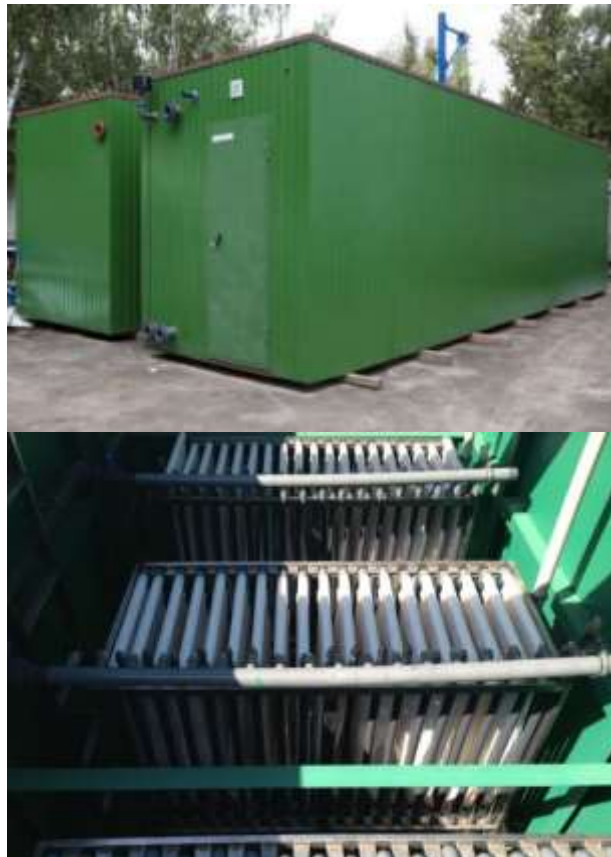
Рисунок 1 – Общий вид системы биологической очистки и мембранного блока с погружными модулями
