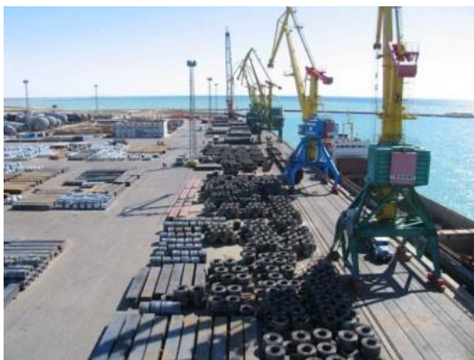
Рисунок 1 - Складирование металла в один ярус на складе открытого хранения порта Актау
