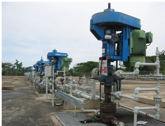
Рисунок 1 – Общий вид электропривода винтового насоса
